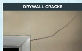
DRYWALL CRACKS
